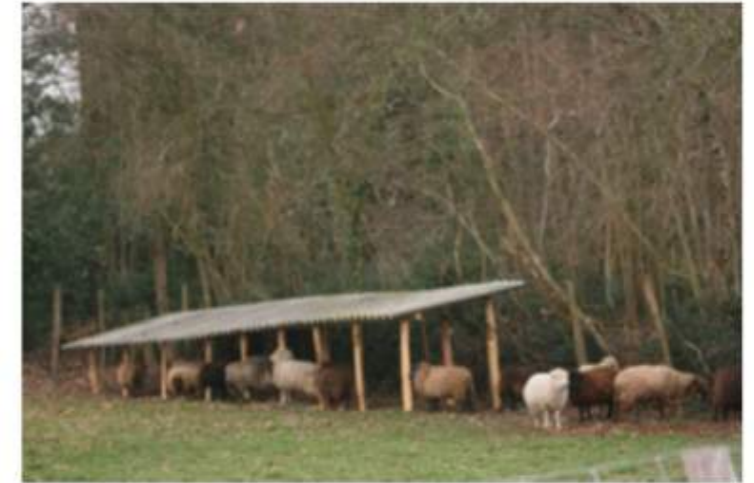
Exemple d'abri simple. (source : http://jouessant-mouton.over-blog.com ) Attention à bien veiller à orienter la pente du toit de façon à ce que l'eau ne ruisselle pas sous l'abri.
